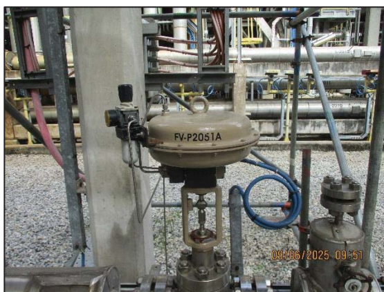
รูปที่ 3.56 Pressure Flow Control Valve
