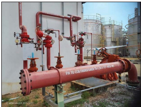
รูปที่ 3.33 ระบบท่อน้ำดับเพลิง
