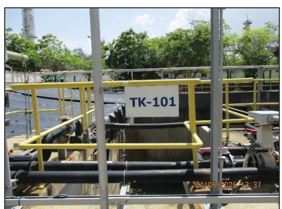
รูปที่ 3.12 บ่อ Equalization (TK 101)
