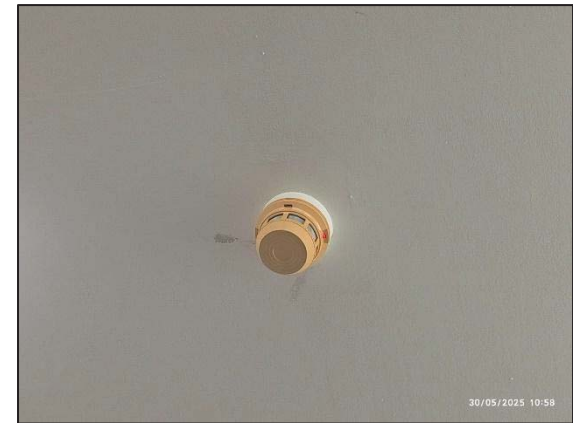
รูปที่ 3.34 Smoke Detector
