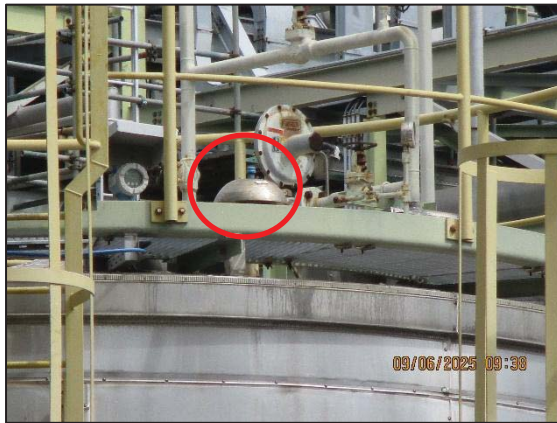
รูปที่ 3.47 Pressure Safety Valve
