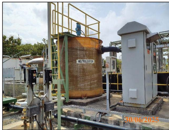
รูปที่ 3.3 บ่อ Neutralization (TK 201)
