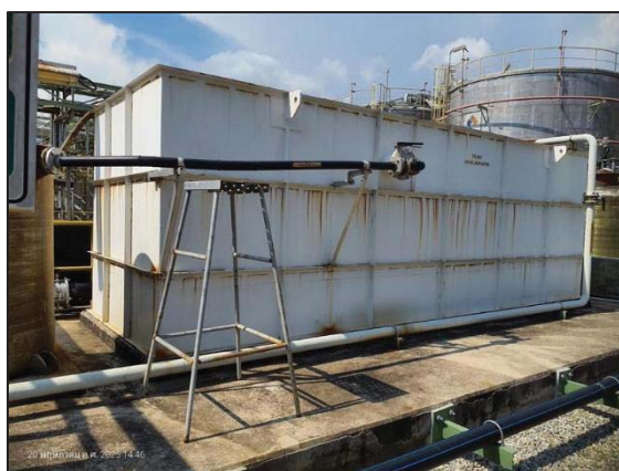
รูปที่ 3.15 Oil-water Separator (CPI)
