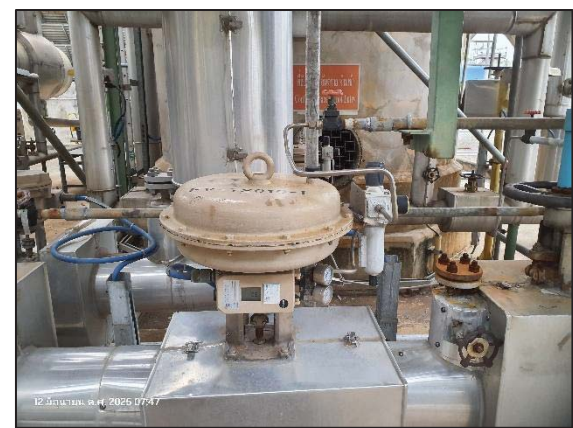
รูปที่ 3.4 Flow Controller
